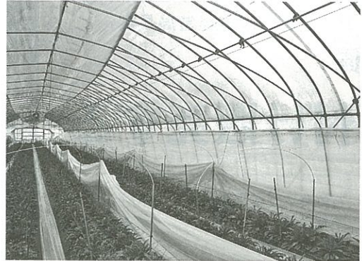
トンネルに加え、サイドは中空二層、上部は空気膜と可能な限り多層化を図る。送風機の設置で温度むらを解消し通気性を高めた
